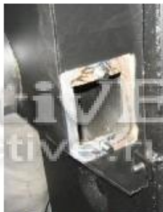
Рисунок 12. Отверстие для чистки адаптера дыма
