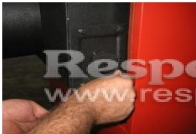
Рисунок 11. Снятие заглушки для чистки адаптера дыма
